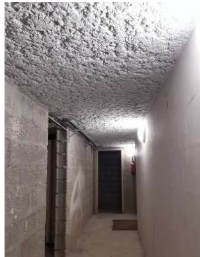
Isolation en sous face des caves © RBBD
